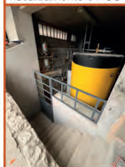
Installazione nuovo impianto di riscaldamento e ACS
