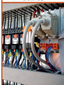
Realizzazione di nuovo impianto elettrico
