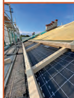
Isolamento termico della copertura
