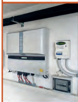
Installazione di sistema di accumulo elettrico
