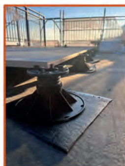
Isolamento termico dei terrazzi
