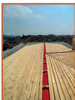
Sistemazione e ripristino della copertura interna
